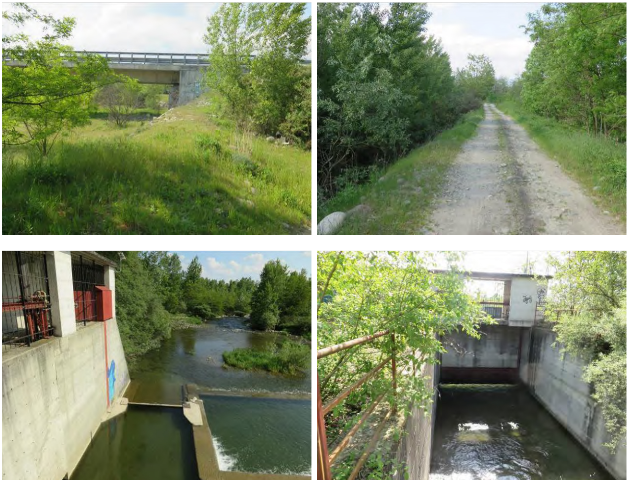
Figura 23 – Interventi sulla sponda sinistra del torrente Orco successivi agli ultimi eventi alluvionali: arginatura a valle del ponte della SP 565 e nuova opera di presa del rio Vercellino.
