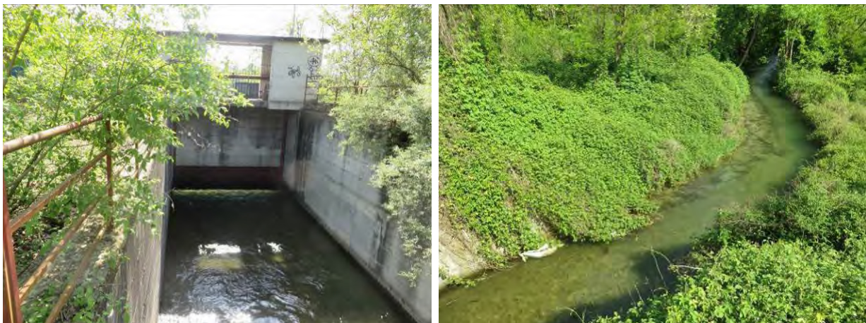
Figura 3 – Vista del rio Vercellino in corrispondenza dell'opera di presa in sinistra idrografica del torrente Orco e a valle della provinciale Rivarolo – Ozegna.
