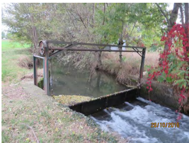
Figura 41 – Esempio di presa irrigua lungo il rio Levesa (via Oglianico), che può interferire con il deflusso di piena in condizioni di semi apertura.
