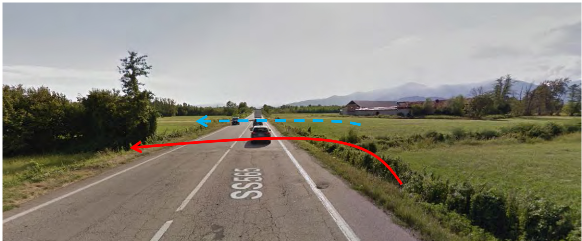
Figura 49 – Possibile fenomeno di tracimazione/sormonto della SP 565 e deflusso tramite il sottopasso stradale.
