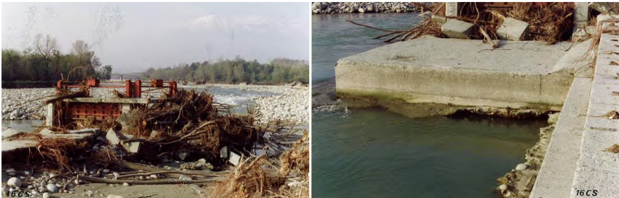
Figura 17 – Opera di presa sul Rio Vercellino post alluvione del 1993 (distrutta nell’evento del 2000).
