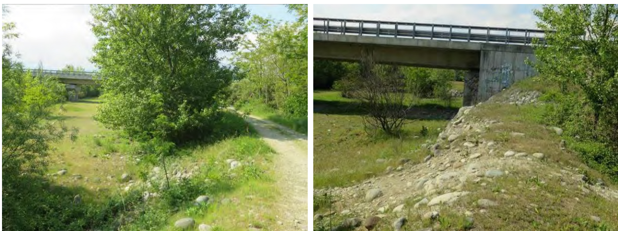
Figura 47 – Vista dell'argine esistente sulla sponda sinistra dell'Orco alla presa del Vercellino: sono evidenti le condizioni di non perfetta manutenzione e possibile debolezza strutturale.
