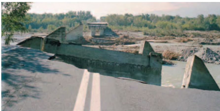
Figura 14 – Crollo del ponte della SP565 a monte di Rivarolo Canavese nell'ottobre 2000 (ARPA Piemonte).
