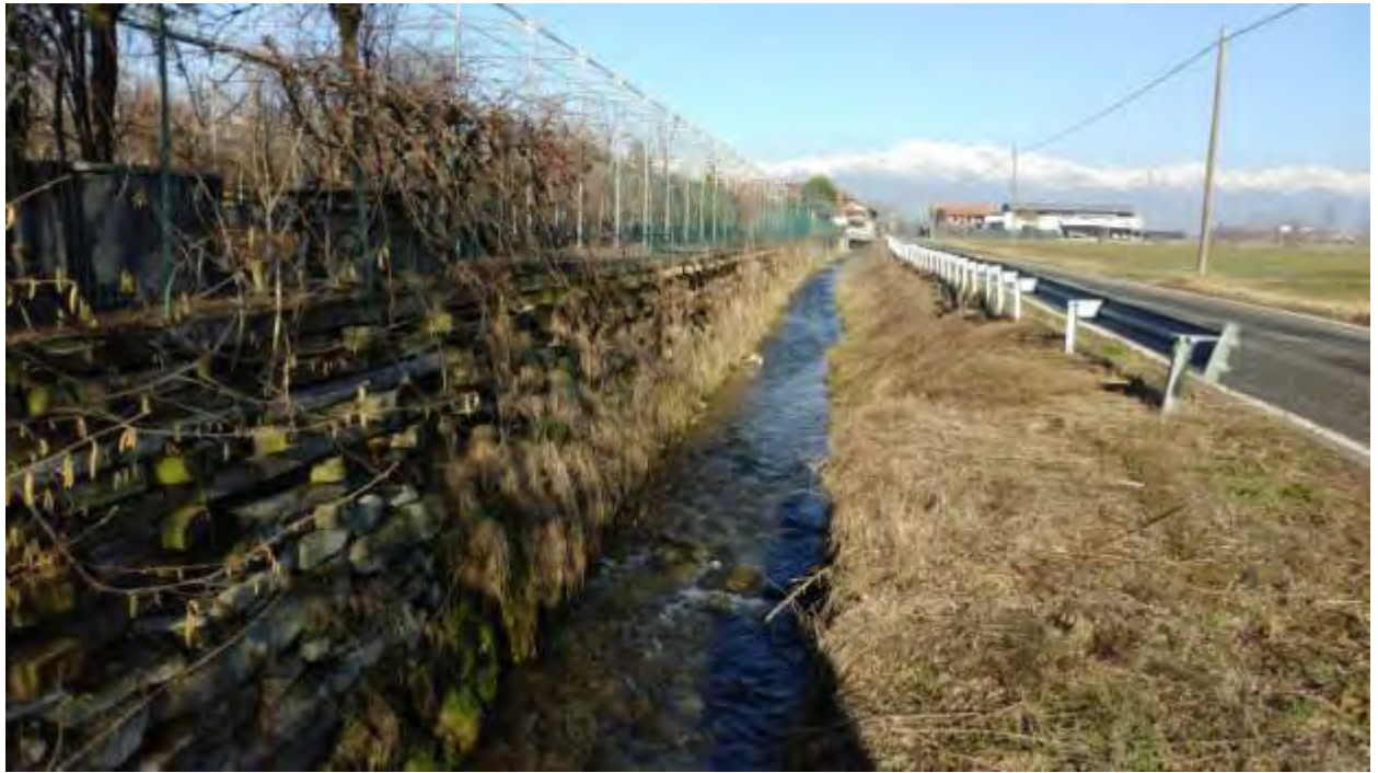
Foto 2: vista da valle
