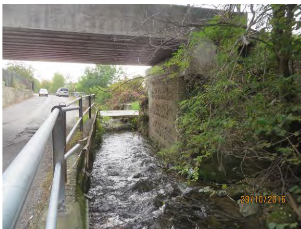
Figura 40 – Esempio di ponticello lungo il rio Levesa (via Crosa), che interferisce con il deflusso di piena.
